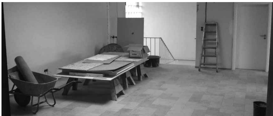
Im Flur wurde der Zugang zum Treppenhaus wieder geöffnet.
