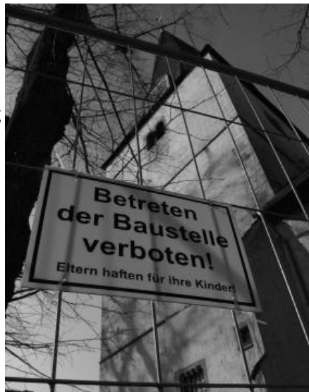
Bauzaun an der. St. Johannis-Kirche
