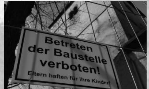
St. Johannis-Kirche: Sanierungsarbeiten starten
