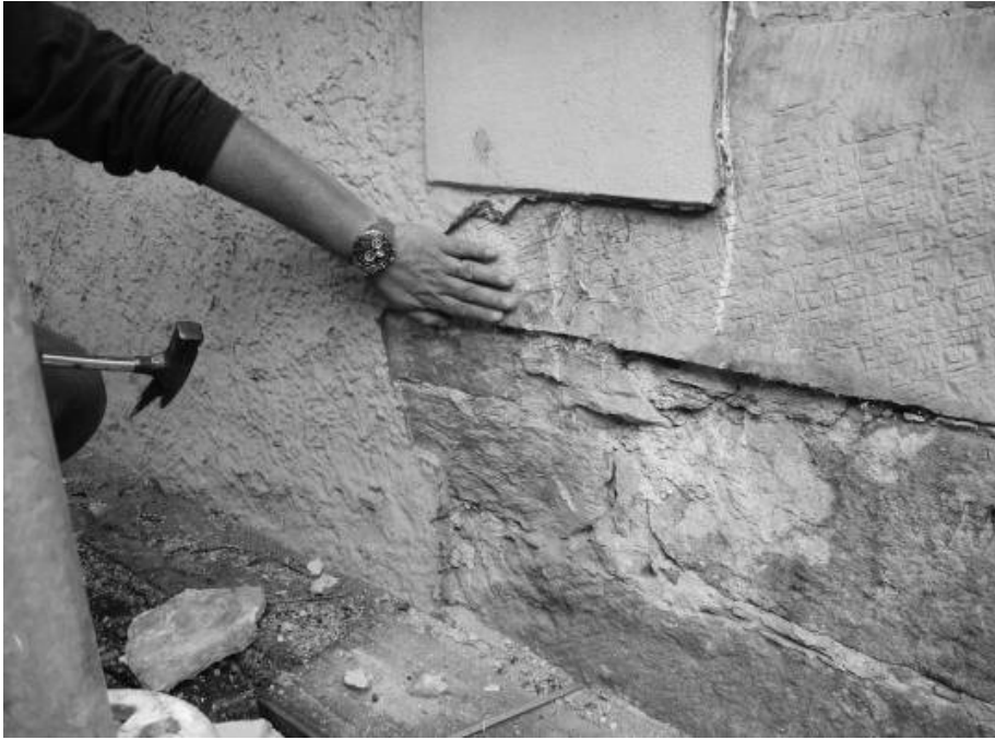
Loser Putz über einem der Ecksteine am Turm.
